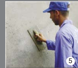
تركيب طبقة الضهارة
